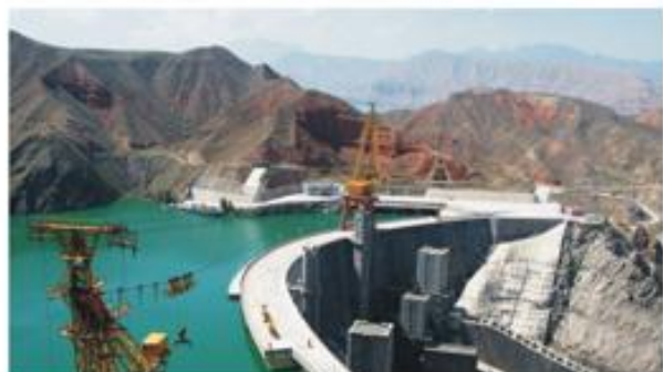
李家峡水库大坝用中化798成功地进行了F 32 断层的固结补强施工
