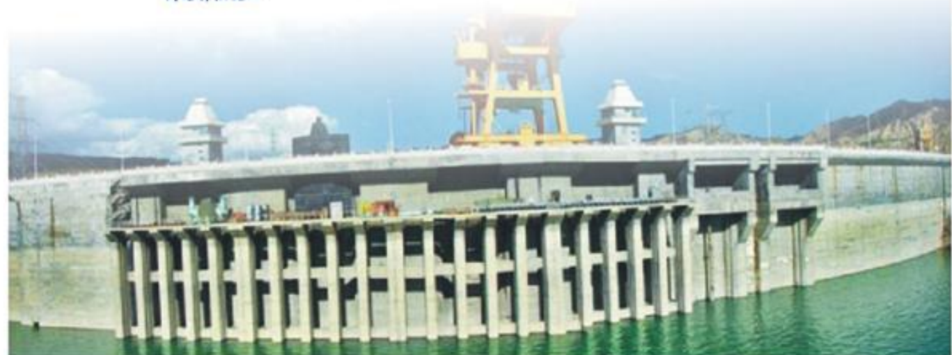
龙羊峡水库大坝坝肩的G 1 伟晶岩劈理带用中化798浆材处理成功，这是世界上首例用复合灌注高渗透性浆材的方法代替传统的开挖回填砾来处理低渗透性软基的大规模施工实例
