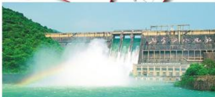
新丰江水电站用YDS-1处理坝体砼裂缝，效果良好
